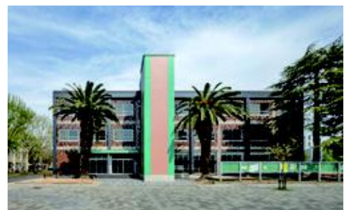
改修後のA3棟(学生センター)
